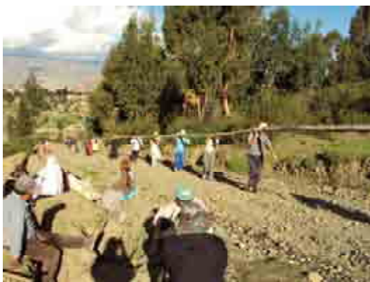
Traslado e instalación de tuberías de agua
